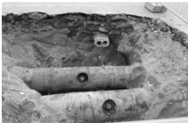
道路下に埋設されている大小の配水管
