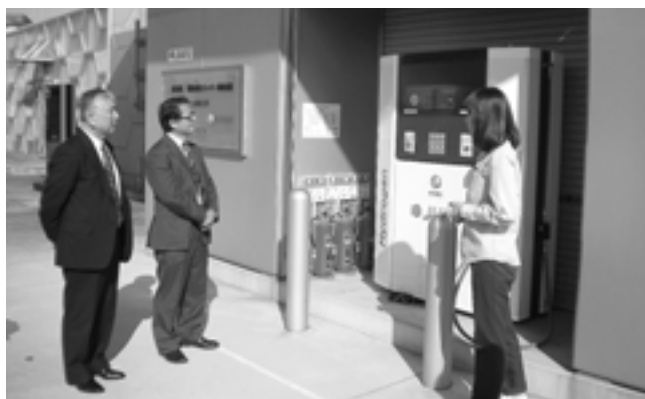
九州大学伊都キャンパス内に設置された水素ステーション
