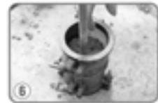
⑥ シールの半程までコンクリートの打設が終わったら棒をはずし、最後まで打設を完了する。
