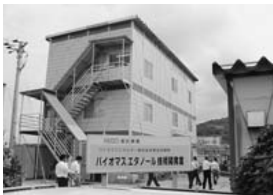
バイオエタノール製造実証実験プラント（出水市日揮株）
