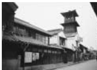
城下町に時を知らせてきた「時の鐘」は今も1日4回鐘が鳴る。市民の間では、無意識のうちに「時の鐘」の高さを超えないことが建物の高さの目安だった。今は、伝統的建造物群保存地区に指定され、11mの高さ制限を設けている
