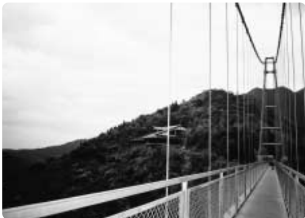
歩いて渡ることができる世界最大級の吊橋「照葉大吊橋」。渓谷にかけられた橋の高さは142m。高所恐怖症の方は遠慮した方がベター
