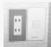
客室内のLANコンセント
