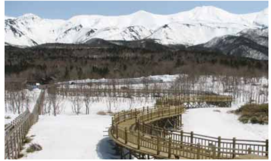
今年春に設置された電気柵併設の高架木道 (写真右側、左側は既存の木道)
