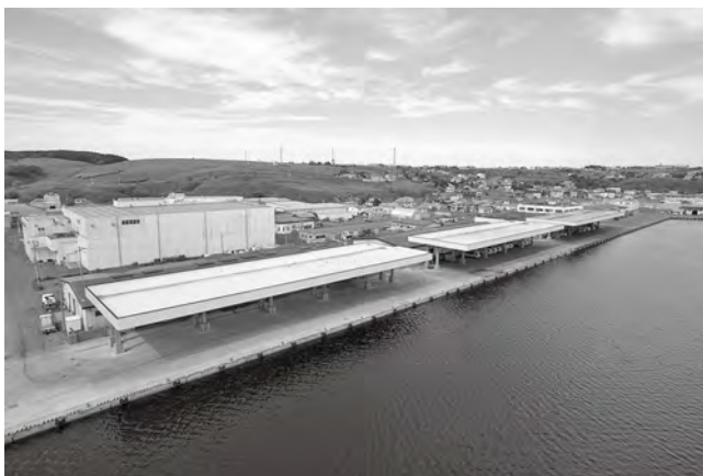
根室港 屋根付き岸壁（令和7年供用）
