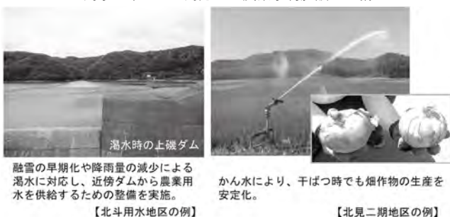
渇水・干ばつに対応した農業水利施設の整備
