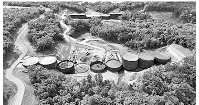
熊の沢川3号砂防堰堤
