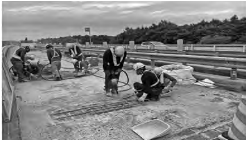
構造物の修繕（床板補修）
