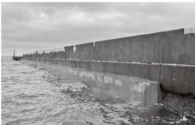
プレキャスト型枠を活用した長寿命化対策
