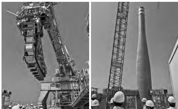
マタバリ港石炭岸壁のアンローダー（左） マタバリ石炭火力発電所の煙突（右）
