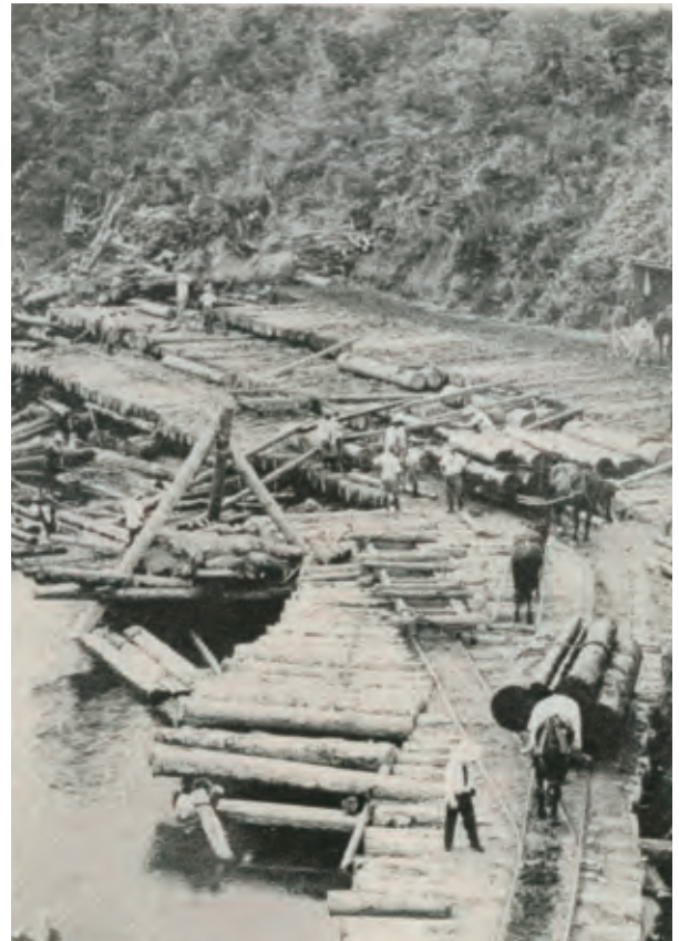
写真－3 湧別川に設けられた網場 （遠軽町丸瀬布東町） 馬鉄で石北線丸瀬布駅の土場まで運搬された
