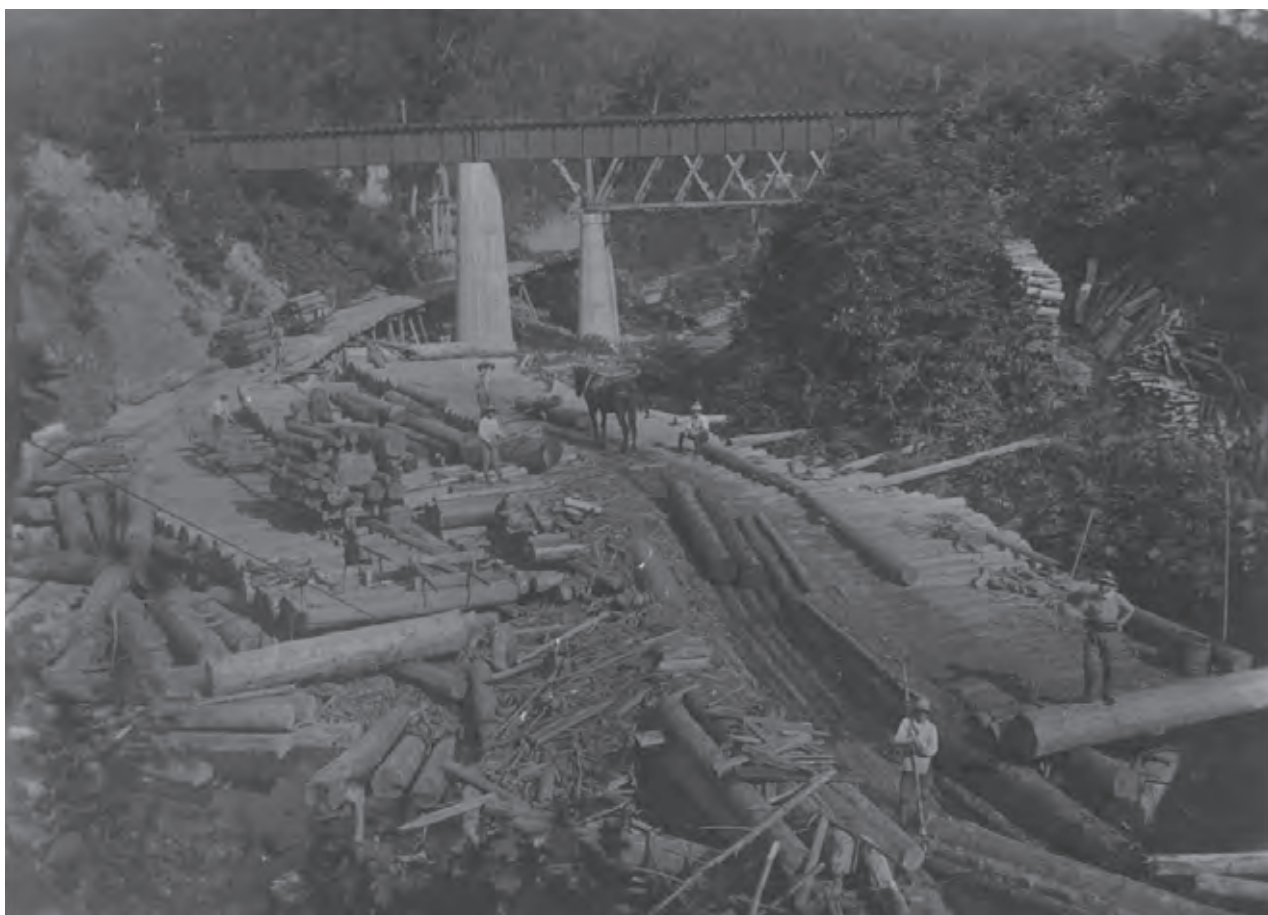
写真－1 丸瀬布川に設けられた網場及び石北線丸瀬布川橋梁（手前）と未完成の武利意森林鉄道2号橋（奥側） 上流の上丸方面から流送された木材を堰き止めて、馬鉄で1927（昭和2）年10月10日開業の丸瀬布駅の土場まで運搬していたと思われます。（1927（昭和2）年撮影と思われる写真）
