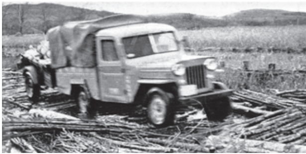
浮橋を走行して建築資材を運搬
