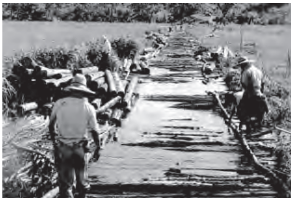
写真-2 浮橋による道路作設
