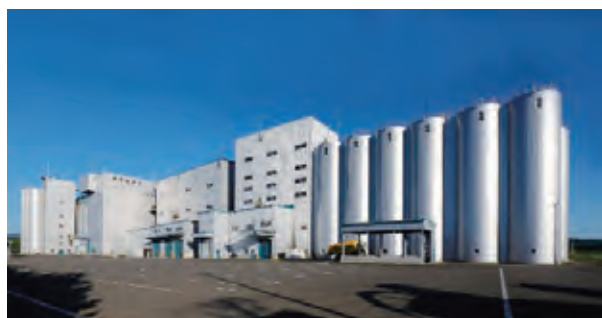
写真-3 小麦乾燥調製貯蔵施設(神威工場)
