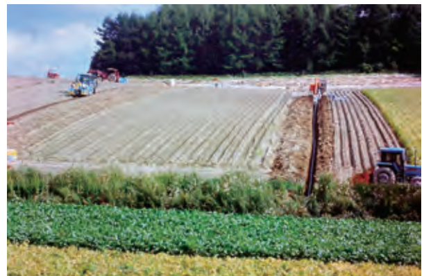
写真－3 暗渠排水工 (美瑛町、1995) 筆者撮影
