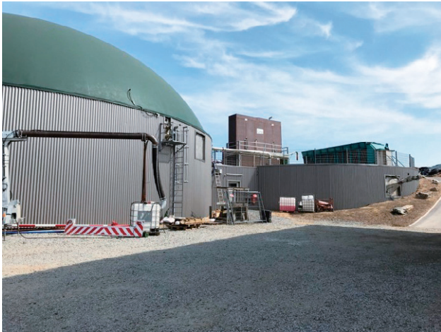
写真2 調整力提供契約をするバイオガスプラント (出典) 著者撮影
