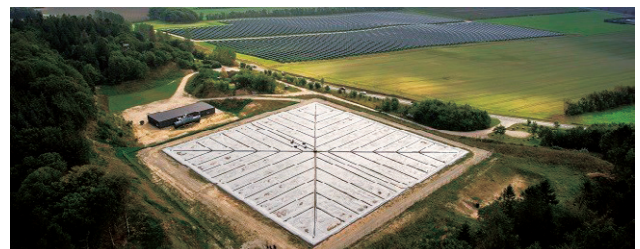
写真2 ドロニンググルン太陽熱収集（奥）、季節間蓄熱槽（手前）
