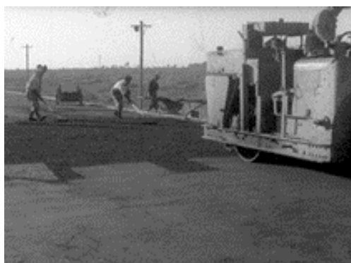
写真-47 レーキマンの敷き均し （出典）札幌開発建設部
