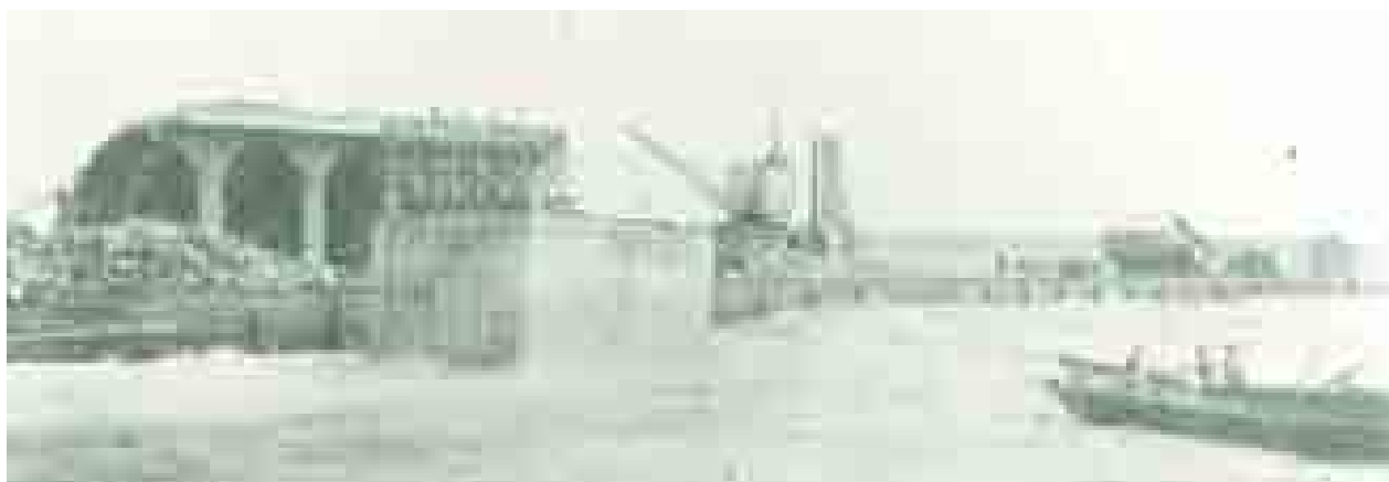
写真-13 建設中の稚内港北防波堤ドーム
