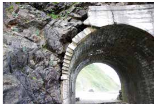
写真-19 フンコツ隧道 (近景) 筆者撮影
