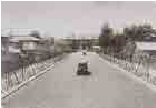
写真-23 建設当時の木塊舗装とイチョウ並木 （出典）北海道道路誌 大正14年 北海道庁
