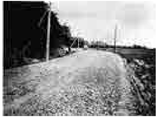
写真-31 碎石の舗装 （出典）札幌開発建設部（旧道路情報館所蔵写真帳）
