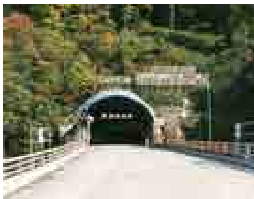
写真-66 モトツトンネル (出典) H18土木資産調査業務報告書(室蘭開発建設部)
