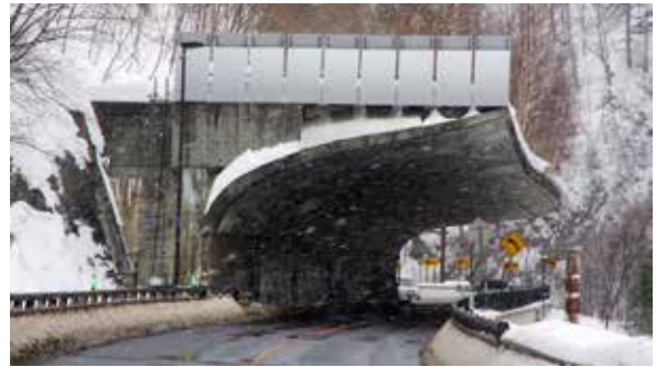
写真-56 雪を落とせるよう柱が無い仙境覆道 筆者撮影
