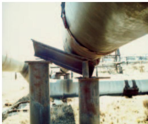
図 1.8.5. 凍着凍上によるパイプの不
