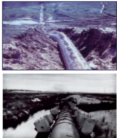
図 1.8.6. 地下埋設パイプの洗堀
