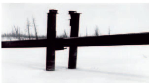
図 1.8.4. 西シベリア天然ガスパイプラインの凍着凍上被害
