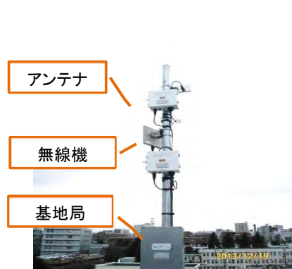
図 4 NerveNet 無線設備 (NICT による東北大学構内設備)
