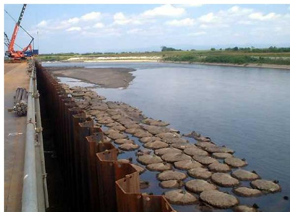
写真-7 洗掘防止工施工状況
