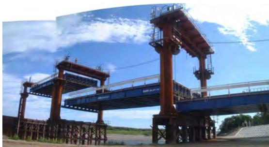
写真-6 仮栈橋ジャッキアップ作業状況
