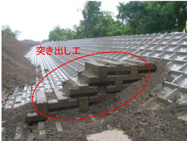
図-3 突き出し工
