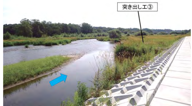
図-7 調査箇所1 突き出し工③周辺 (H27撮影)
