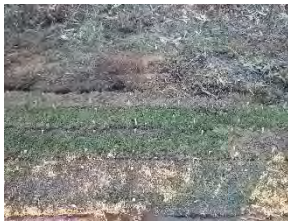
▲施工直後(9月6日)
