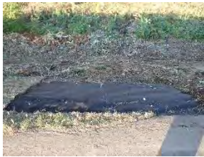
▲施工直後(9月6日)
