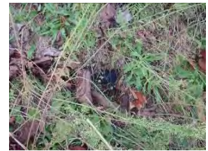
▲芝の脱落状況
