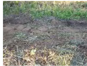
▲施工直後(9月6日)
