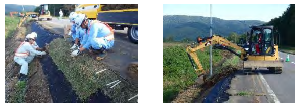
▲張芝施工 ▲すき取り土埋戻し
