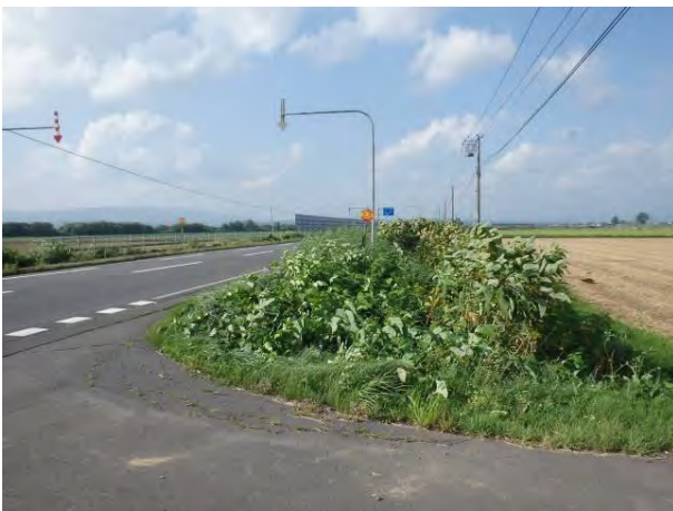
写真-1 雑草による交差点の視距障害 (国道40号)
