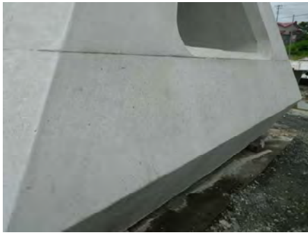
写真-12 ケース3-1の外観
