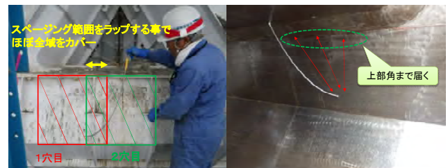
写真-6 空気抜孔3穴から曲げ加工したφ80mm鉄棒でスペーシングする方法
