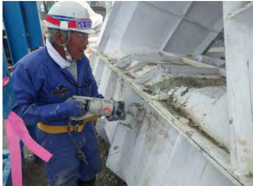
写真-2 壁バイブレータによる締固め
