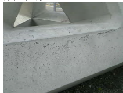
写真-11 基本ケースの外観
