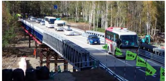
写真7：開通した仮橋
