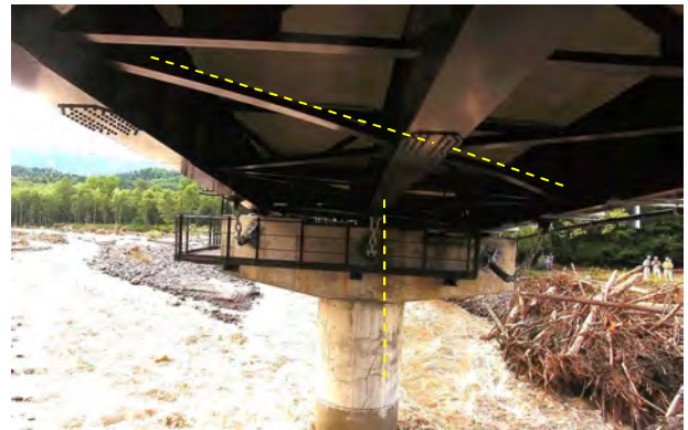
写真2：UAVからの写真(上・下部工のゆがみ・傾きを確認)
