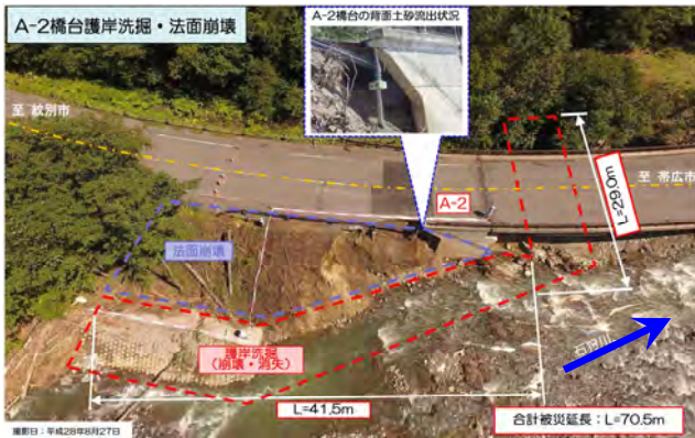
図4：高原大橋の被災概要
