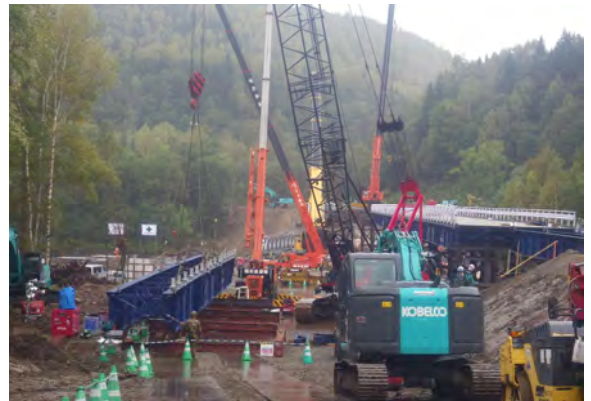
写真 5 : 桁架設状況 (上 : トラス橋、下 : 鉸桁部)
