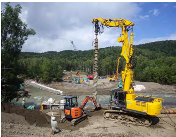
写真 4 : A1 側(帯広側)の削孔機
