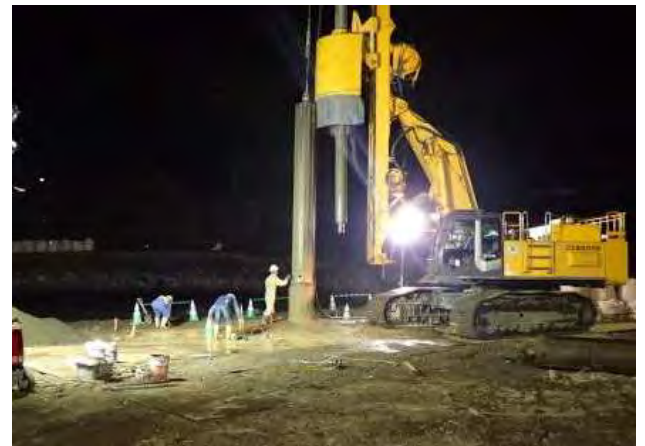
写真3：夜間の削孔作業
