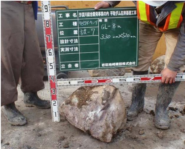
写真2 ケーシング掘削機にて切り出した巨礫の一部
