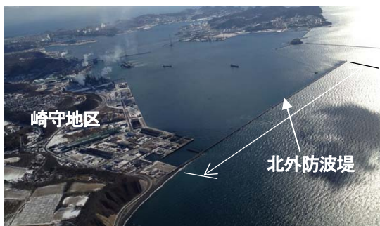
写真-1 北外防波堤と崎守地区
