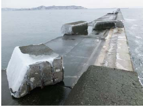
写真-4 胸壁の被災状況
