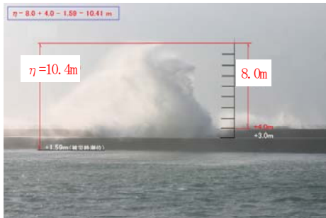
写真-5 被災時の越波状況
