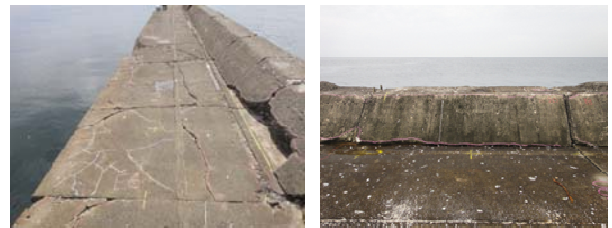
写真-2 上部工の劣化状況
