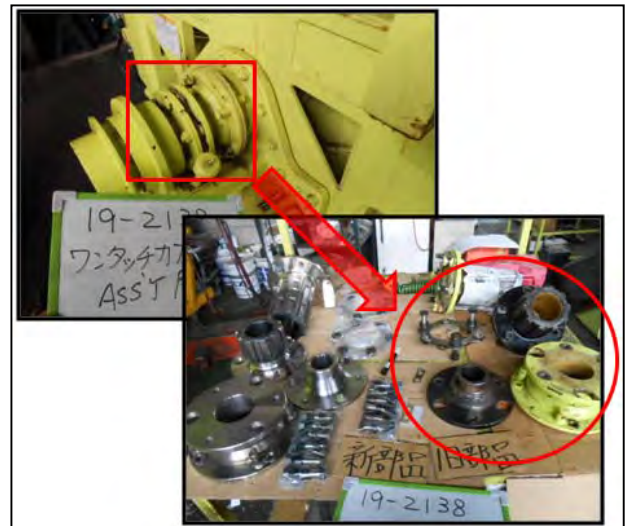
写真-1 破損したワンタッチカブラ
