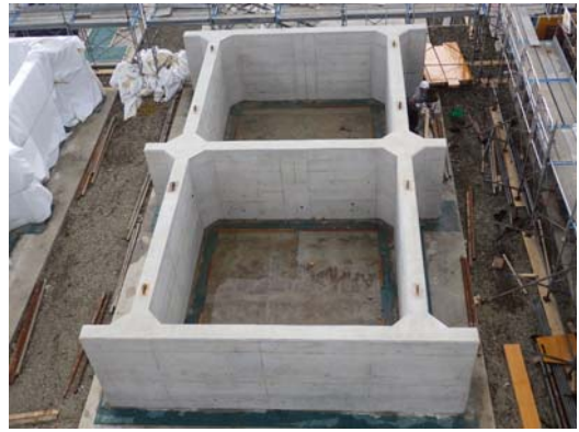
写真－4 瀬棚港における施工状況
