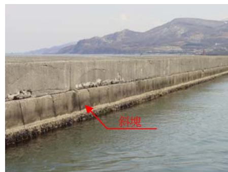
写真－２ 小樽港北防波堤
