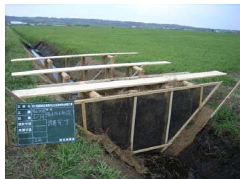
写真-4 汚濁処理施設
