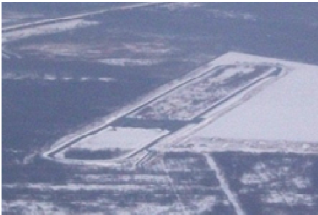
図-7 苫小牧寒地試験道路
