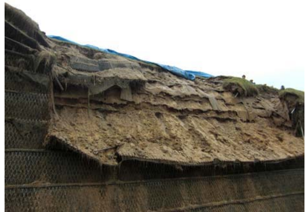
写真-1 補強土壁の変状事例
