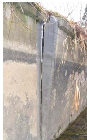
写真1 傾倒状況
