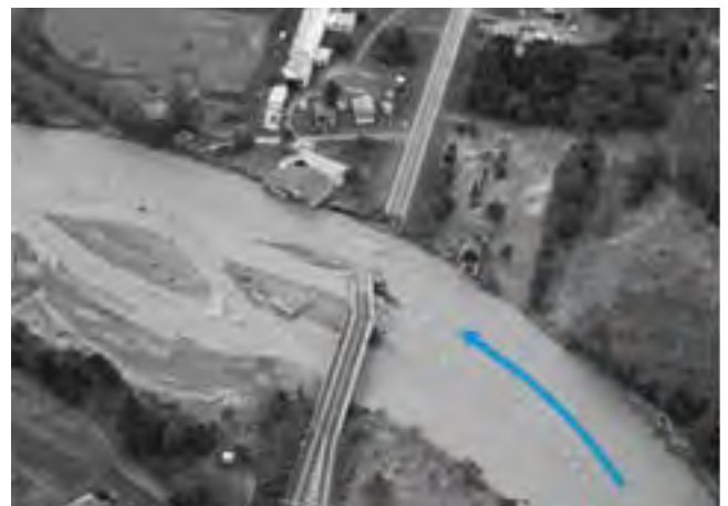
写真6 沙流川に架かる国道274号・千呂露橋(日高町)の落橋
