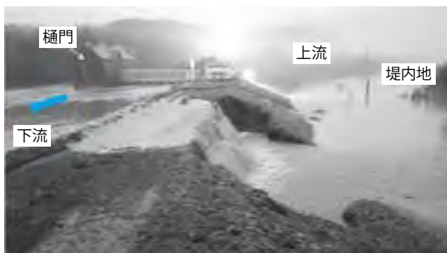
写真4 常呂川の越流時の状況(日吉30号樋門、8月22日4時頃の状況)(北海道開発局網走開発建設部提供資料に加筆)
