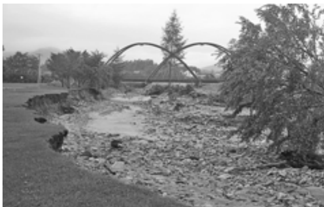
写真3 ペケレベツ川の河岸決壊状況、上) 石山橋周辺（9/1撮影、左右岸の連続的な河岸決壊状況）（PASCO提供）、下) 石山橋下流（9/6調査団撮影、河岸決壊の状況）
