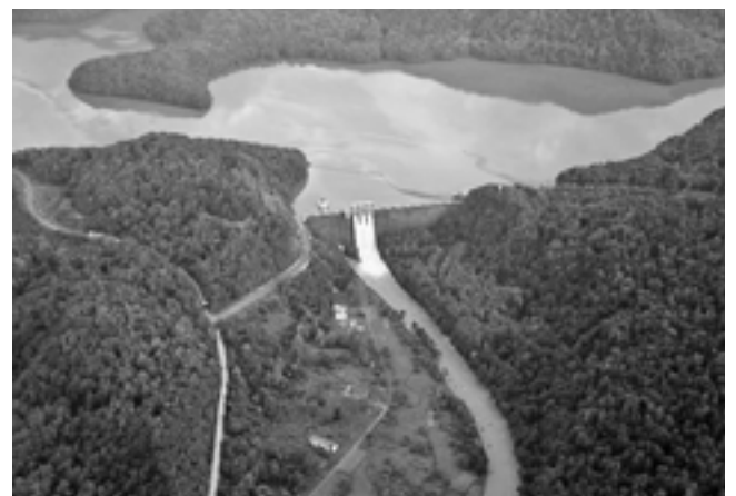
写真2 金山ダムの貯水状況（8月31日撮影） （北海道開発局提供）
