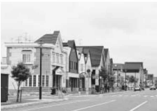
本通地区の駅前商店街。大雪の山をイメージした三角の屋根と色調が統一され、美しい
