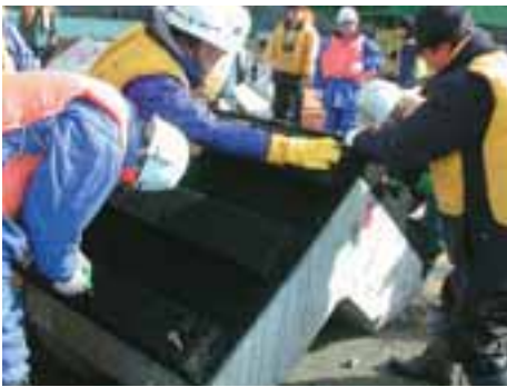
網状構造培地とコンクリートブロックを組み合わせ、厚岸沖に投入した藻場再生実験
