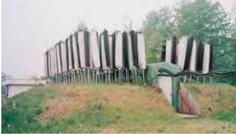
人工永久凍土を用いた低温貯蔵庫（帯広畜産大学）
