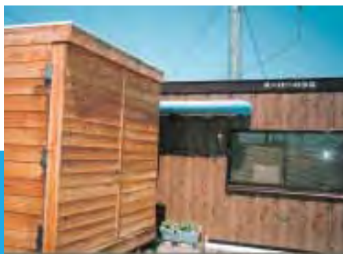
写真3 カラマツ材の冷房施設(左)と冷房建物
